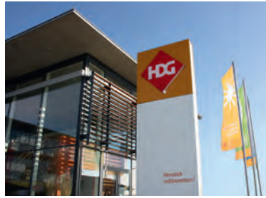
Færdiggørelse af administrationsbygningen
